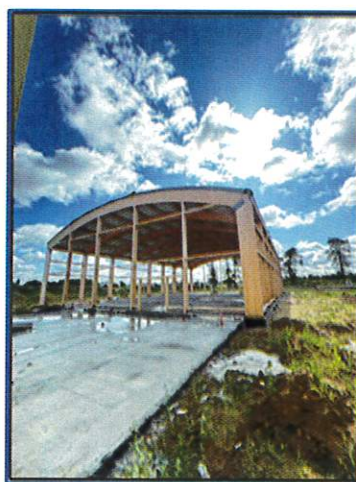
Fot. Budowa nowej hali sportowej przy Szkole Podstawowej w Gościeszowicach
